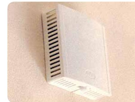
Der Abluftventilator im Bad und WC kann z.B. an einen vorhandenen Schacht angeschlossen werden. Der Betrieb sollte über eine Zeitschaltuhr mit bedarfsgerechter Programmierung oder eine feuchtegeführte Regelung erfolgen. In Mehrfamilienhäusern sind die Brand- und Schallschutzanforderungen zu beachten.
