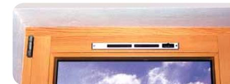
Dies gilt allerdings nur, wenn keine erhöhten Anforderungen an den Schallschutz gestellt werden. In diesen Fällen ist der Einbau eines Außenwandventils sinnvoll, allerdings auch aufwändiger.
