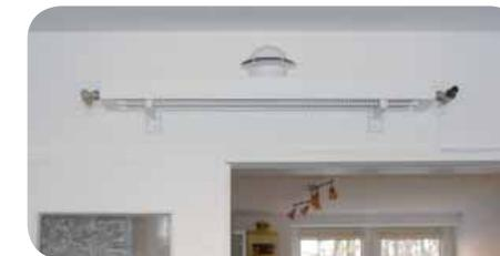
Alle Lüftungsgeräte sind mit Gegenstromwärmetauschern ausgestattet.
