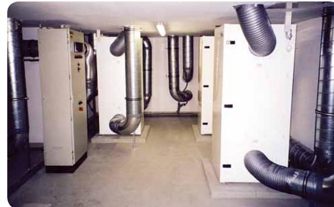
Die fünf Kreuzstrom-Wärmetauscher befinden sich im Haustechnikraum im Keller.
