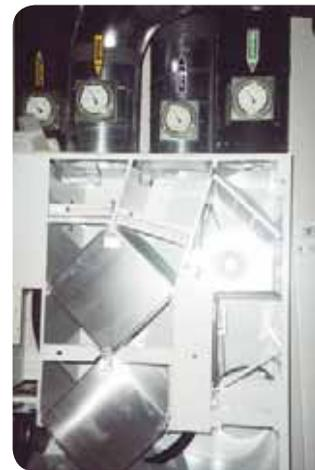
Im Technikraum im Obergeschoss befindet sich für jeden Raum ein Wärmetauscher.
