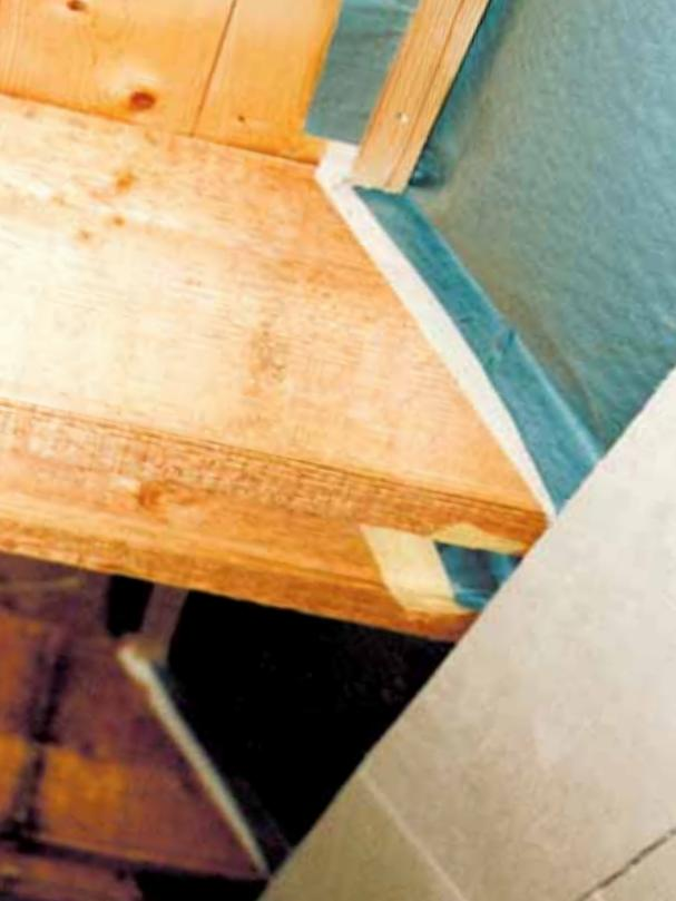
Holzkonstruktionen, z.B. Dächer, werden durch die vollflächig verlegte und an allen Anschlüssen und Durchdringungen sorgfältig angedichtete PE-Folie oder Dampfbremspapier dicht.
