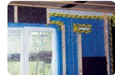
Die Zuluftöffnung sollte möglichst in Fensternähe und Sturzhöhe eingebaut werden. Dabei ist besonders auf den luftdichten Anschluss zu achten.
