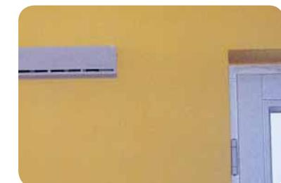
Einbau eines rechteckigen Zuluftventils in die Außenwand eines Wohnhauses.
